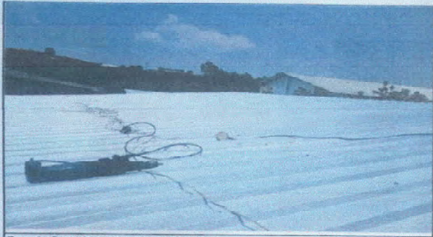
Foto 3: Cambio de techo finalizado
