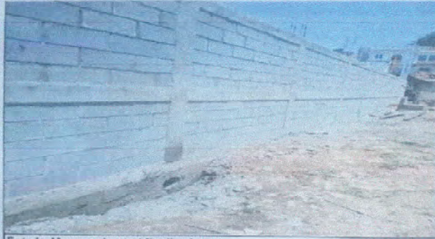
Foto 1: Muro perimetral finalizado
