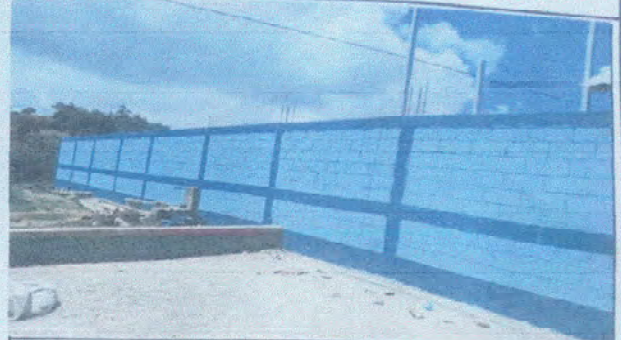
Foto 2: Muro perimetral pintado
